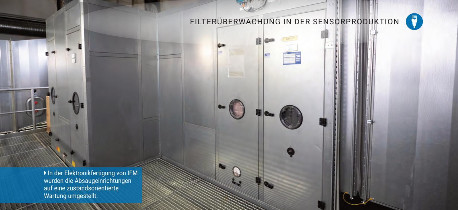
► In der Elektronikfertigung von IFM wurden die Absaugeinrichtungen auf eine zustandsorientierte Wartung umgestellt.
